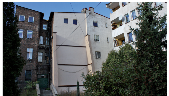
Budynek zabezpieczono przyporami
