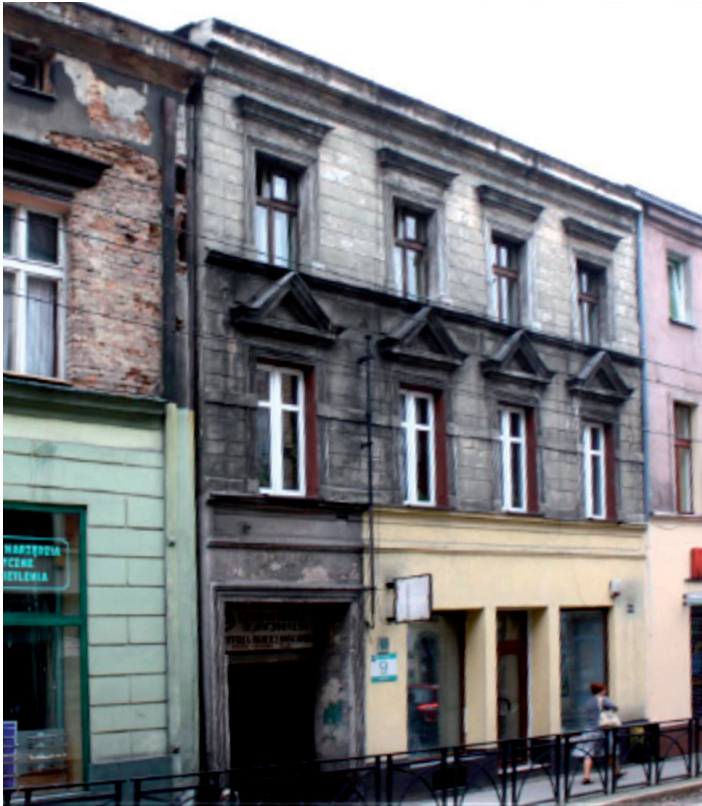
Przed remontem kamienica przygnębiała szarością
