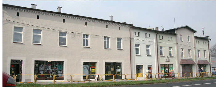
Kamieniczki przed i po renowacji
